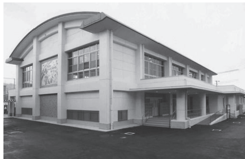
耐震化のため建て替えた体育館 (長岡第八小学校)
