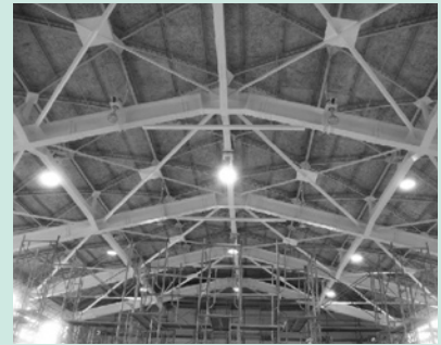
天井補強部材を設置した体育館 （長岡第三小学校）
