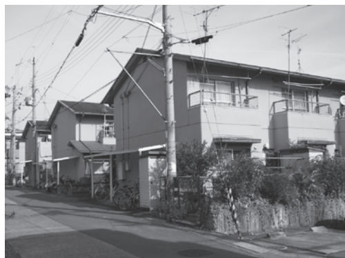
市営住宅の改修に向け「市営住宅等長寿命化計画」を策定
