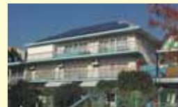
保育園の太陽光発電システム
