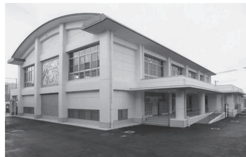
耐震化により建て替えた長岡第八小学校体育館
