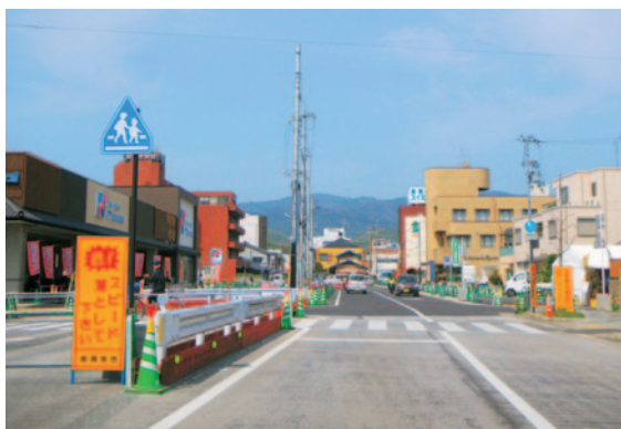
▲長岡京駅前線第3工区
