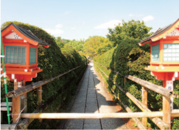
▲木柵が改修される八条ケ池の中堤
