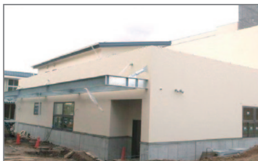
▲建設中の中部共同調理場
