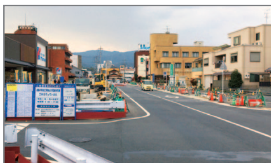
▲長岡京駅前線第 3 工区
