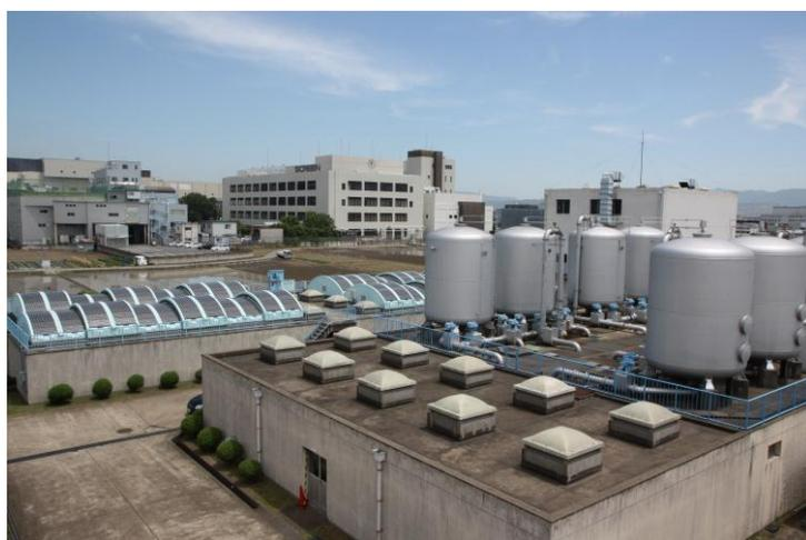
長岡京市上下水道部 東第2浄水場（太陽光設備・急速濾過機）
