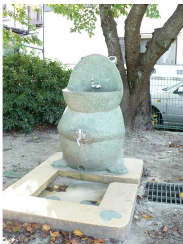
▲ 毎日検査（末端の給水栓）
