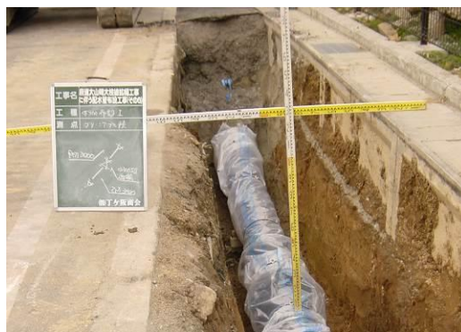
▲ 管路の耐震化事業
