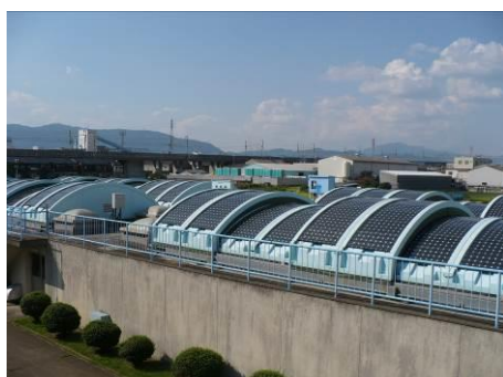
▲ 排水池 (太陽光発電パネル)
