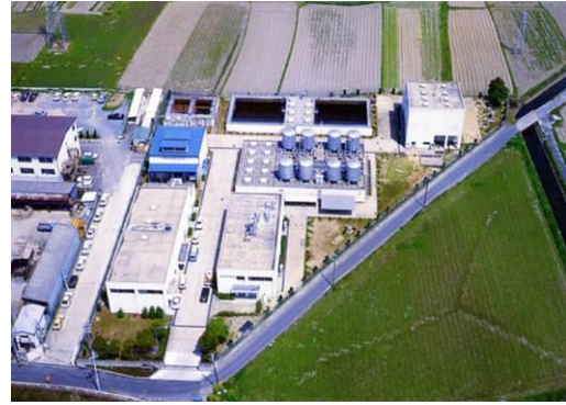
▲ 東第2浄水場 (昭和57年5月稼働)
