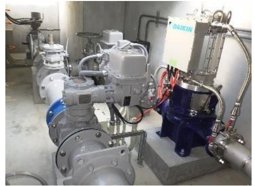
東配水池に設置された小水力発電機
