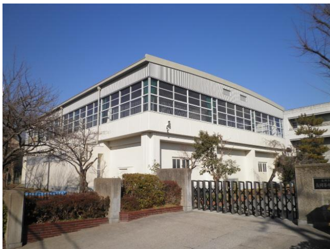
（体育館南東面）
