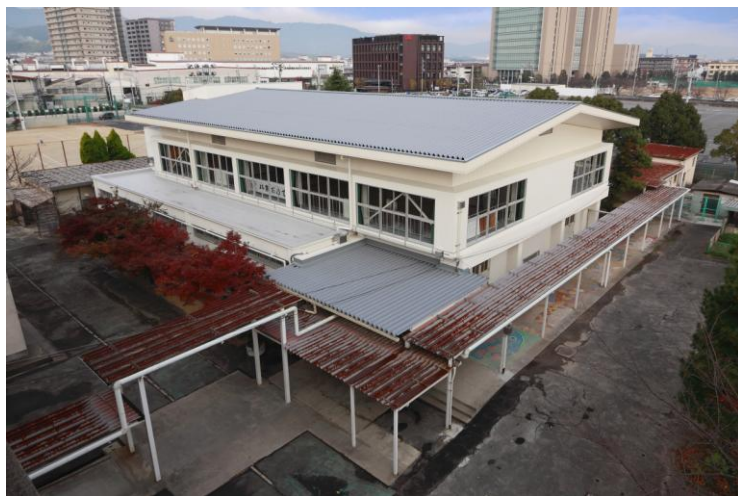
（体育館南東面）
