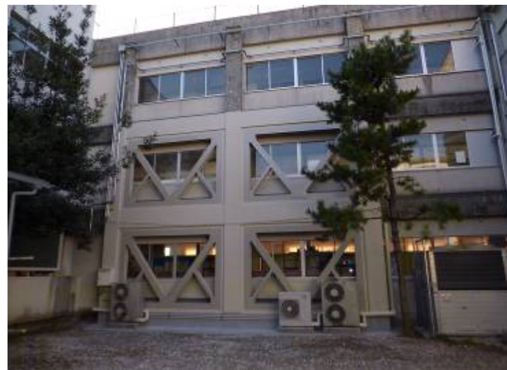
（南棟 北側補強ブレース設置箇所）
