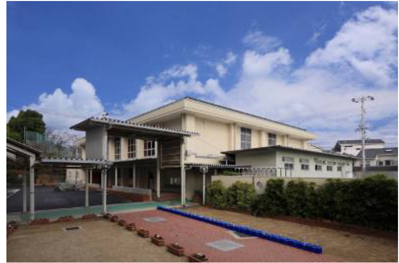
（体育館 南東面）
