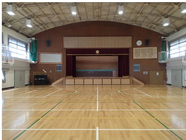
（体育館 天井パネル撤去）
