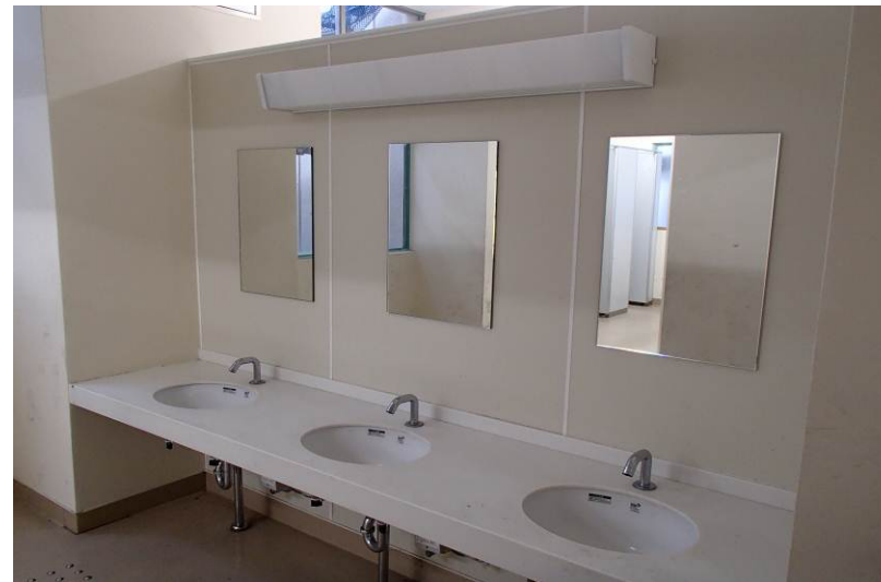
(北棟改修 トイレ)
