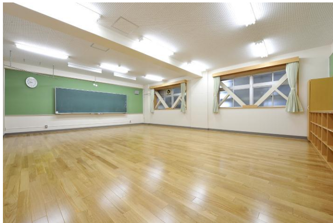
（北棟 普通教室 補強ブレース設置個所）
