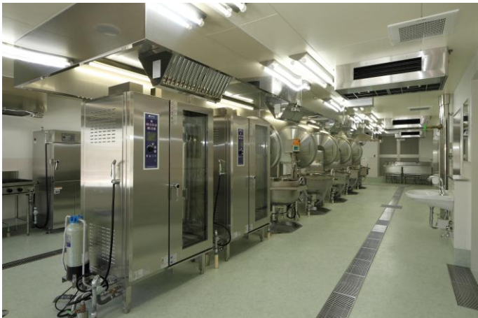
(増築棟 給食室)
