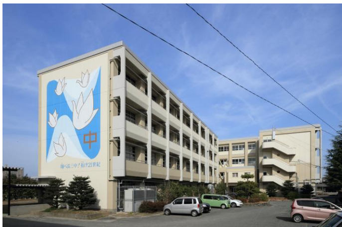
（北西・北中・北東・南棟 南西面）
