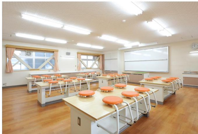
（北棟 特別教室 補強ブレース設置個所）
