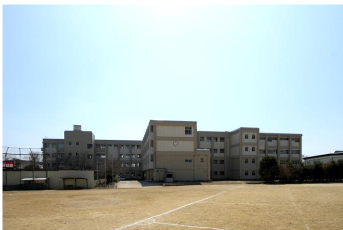
（北西・北中・北東・南棟 北面）
