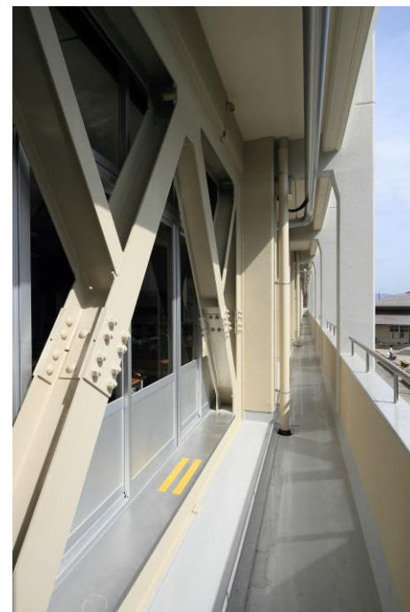
（南棟 補強ブレース設置箇所）
