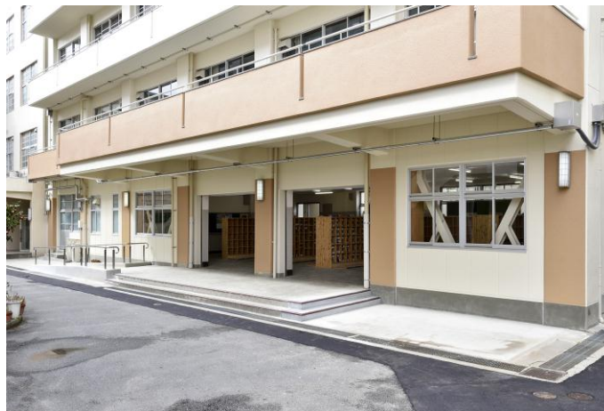
（東棟 補強ブレース設置個所）
