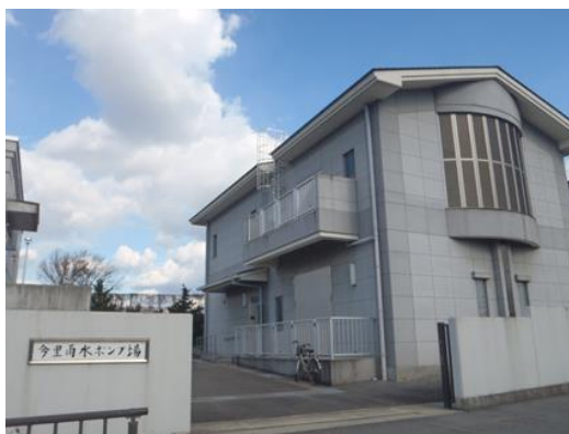
[今里雨水ポンプ場 外景]
