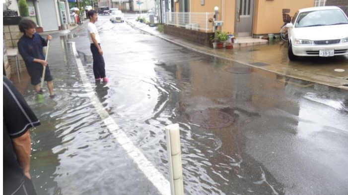
[神足ポンプ場北側・神足2丁目付近H28.9月大雨浸水状況]
