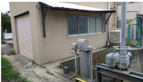
[神足ポンプ場 外景]
