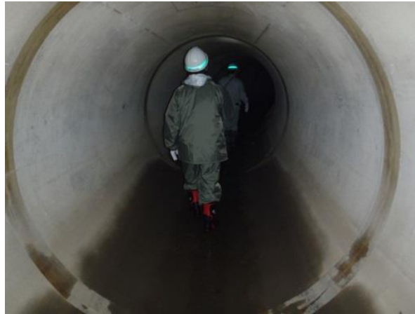
[今里雨水貯留幹線内部 年次点検作業状況]
