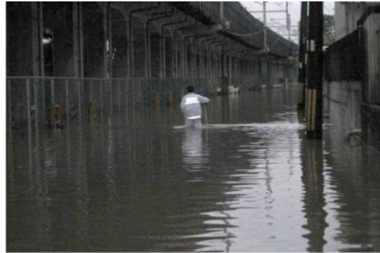
[上の写真は、JR 東海道新幹線下側道(市道)・勝竜寺六ノ坪付近のH22.7月大雨浸水状況]
