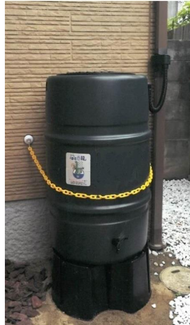
[雨水貯留タンク 設置例]
