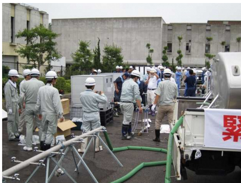
(平成 28 年 7 月 7 日:日本水道協会京都府支部合同訓練の様子)
