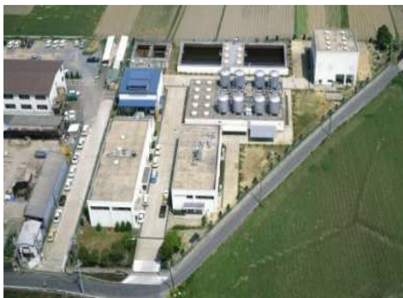
(昭和57年に建設された東第2浄水場の全景)
