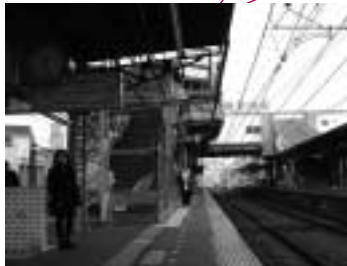
ホームにエスカレーターを新設
