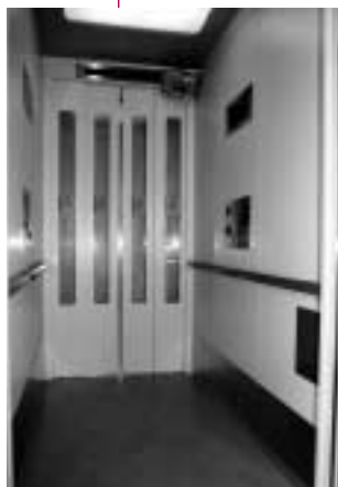
駅ホームのエレベーター。通り抜け式なので、車いすでもラクラク乗り降り
