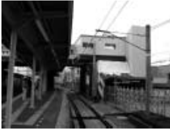
西口にエレベーターを新設
