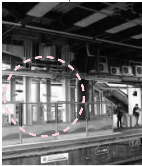
ホームにエレベーターを新設
