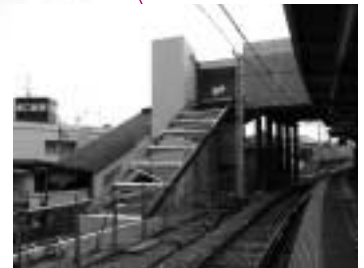
東口にエレベーターとエスカレーターを新設
