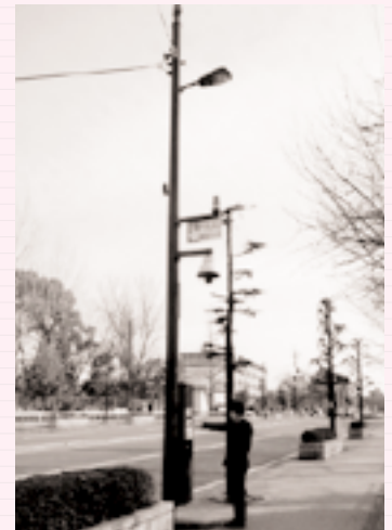
暗い夜道も安全。「スーパー防犯灯」が設置されました。
