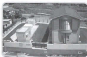
▲今里雨水ポンプ場
