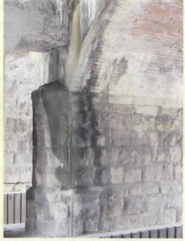
▲時を刻み、今もなお現役のレンガ造り ◀西側先端に付く「く」形の水切り
