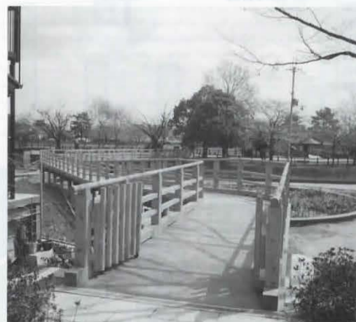
▲完成した八条ヶ池の改修事業
