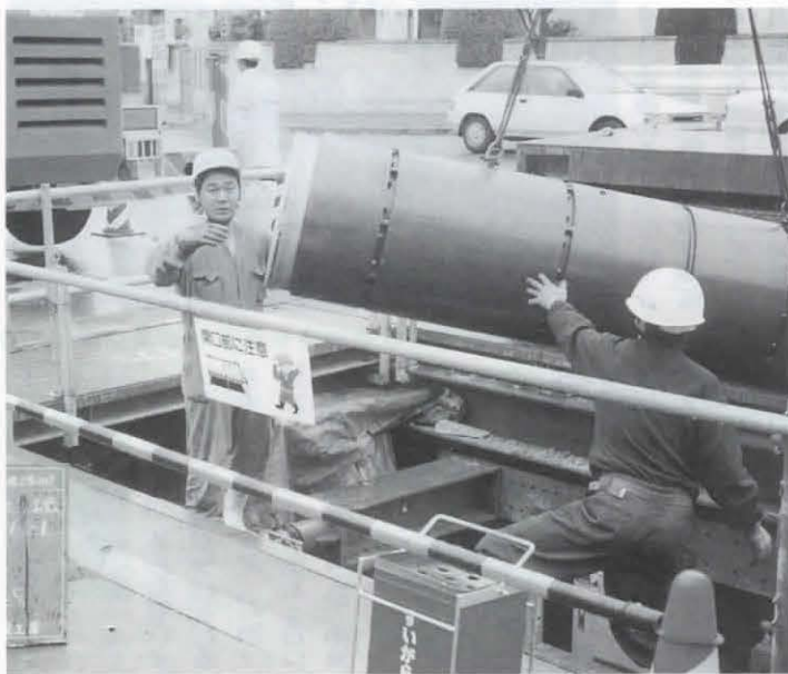
清潔で快適なまちづくりを目指す下水道工事
