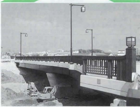
装いも新たになる大門橋新橋
