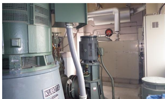
[神足ポンプ場 内部]
