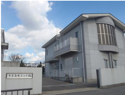
[今里雨水ポンプ場 外景]
