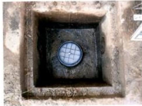
浸透施設（長岡第四中学校地内）
