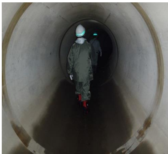
[今里雨水貯留幹線内部 年次点検作業状況]
