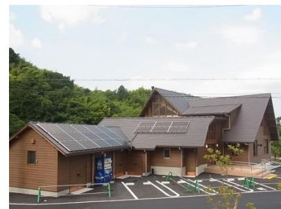
西代里山公園管理棟
