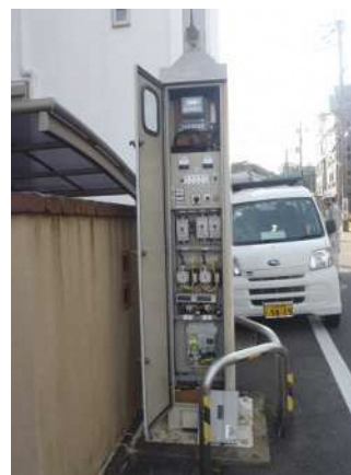
[天神マンホールポンプ制御盤 外景]
