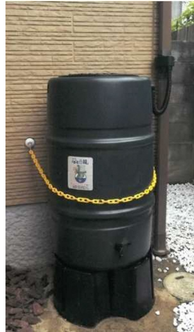
[雨水貯留タンク 設置例]
