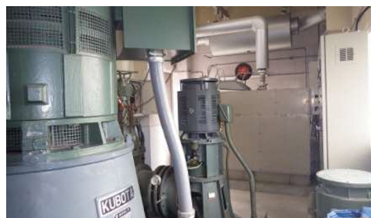
[神足ポンプ場 内部]
