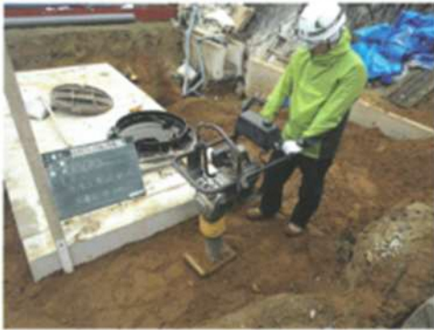
貯留施設（長岡第四中学校地内）
