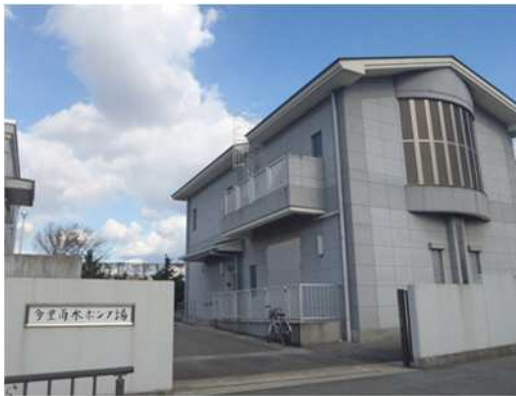
[今里雨水ポンプ場 外景]
