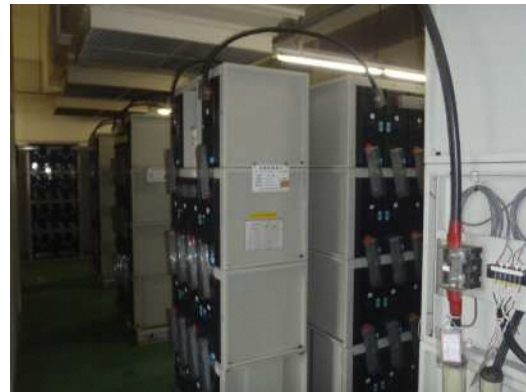
[今里雨水ポンプ場 電気棟1F 蓄電池室]
