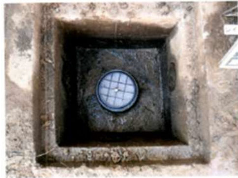
浸透施設（長岡第四中学校地内）
