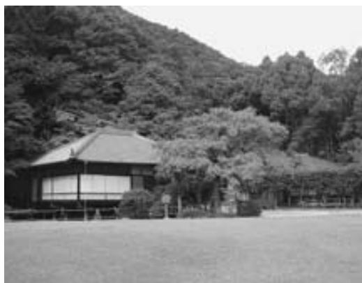
▲聚遠亭（しゅうえんてい）裏千家家元に命名された茶室・楽庵は孝明天皇からの拝領とされ、龍野公園の一角にあり、大変眺望が良く、天気の良い日は遠く瀬戸内海を見ることができ、静かで趣のある庭園です。さくら祭の時にはメイン会場となり、大変賑わいます。
