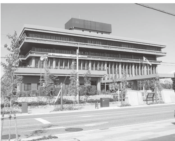
▲各務原市役所。近くには8階建ての産業文化センターもあり、1階から4階は産業関係の施設等が入っており、5階から7階が市役所北庁舎となっています
