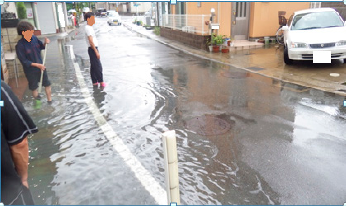
[神足ポンプ場北側・神足2丁目付近 平成28年9月大雨浸水状況]
