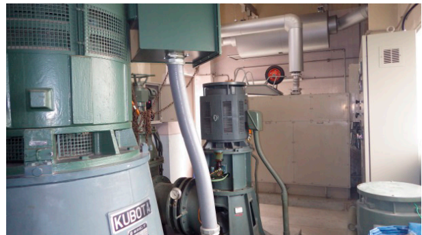
[神足ポンプ場 内部]
