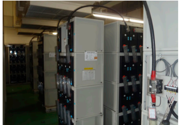
[今里雨水ポンプ場 電気棟1F 蓄電池室]
