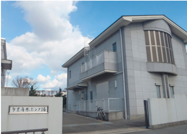
[今里雨水ポンプ場 外景]
