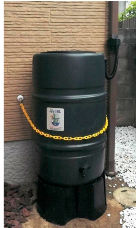
[雨水貯留タンク 設置例]
