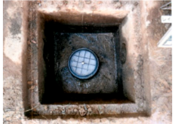
浸透施設（長岡第四中学校地内）
