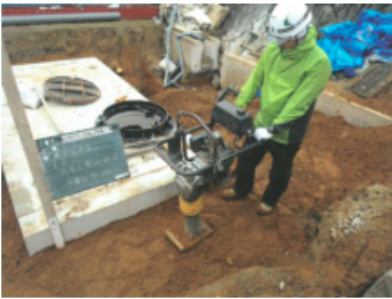
貯留施設（長岡第四中学校地内）
