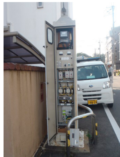
[天神マンホールポンプ制御盤 外景]
