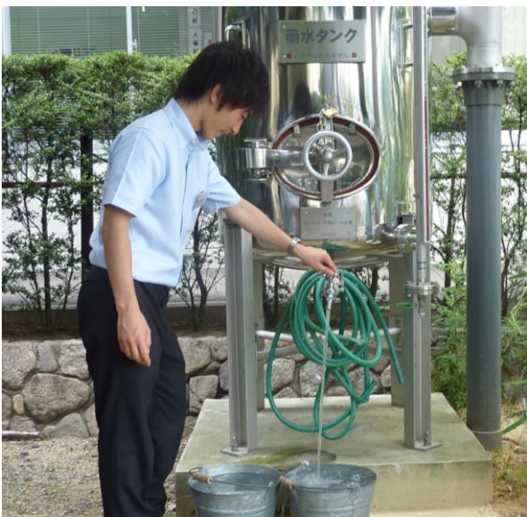
写真 2.2.8 貯留タンクの設置例と貯留雨水の利用例
