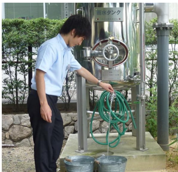
写真 2.2.8 貯留タンクの設置例と貯留雨水の利用例
