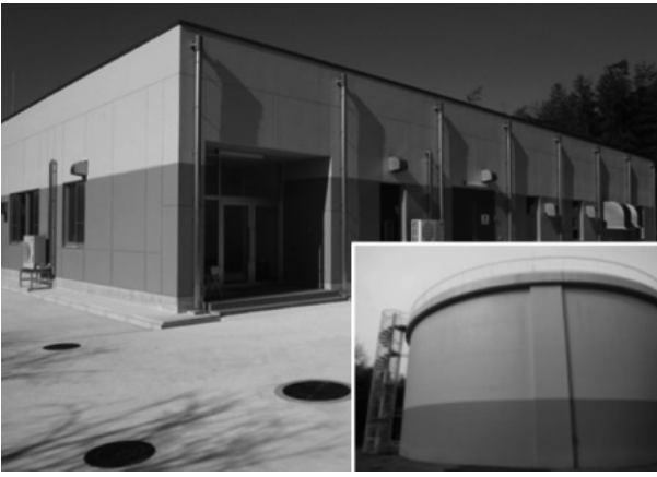
完成した北給水区域の水道施設(ポンプ場と配水池(右下写真))
