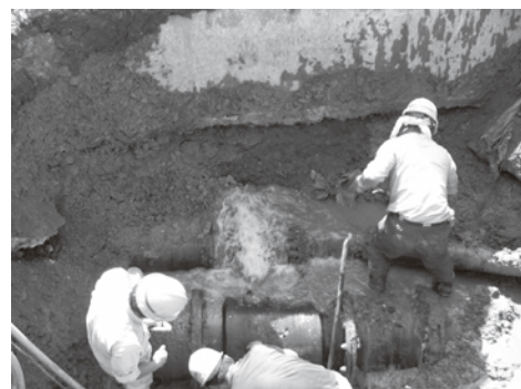
漏水した水道管を修理する様子
