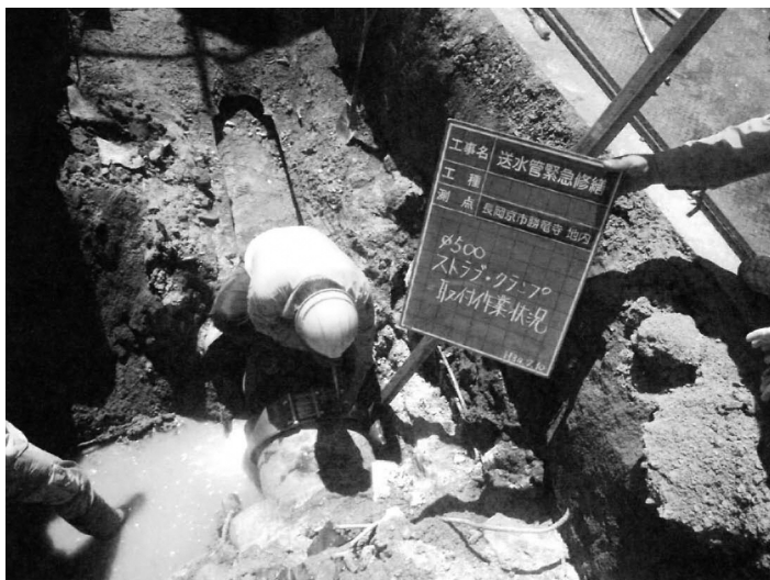
水道管の老朽化により発生した漏水の修繕工事
