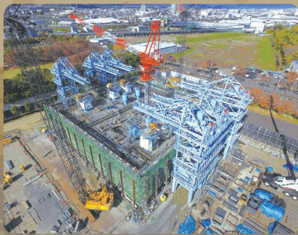
呑龍ポンプ場(工事中)[令和元年11月撮影]
