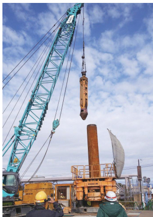
▲左岸に基礎(杭)を作る工事
