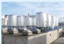
東第2浄水場の耐震補強 (令和3年度から実施予定)
