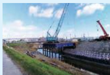
小畑川の水管橋架替 (実施中)
