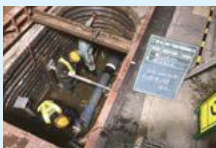
線路下の水道管更新 (令和2年度実施)
