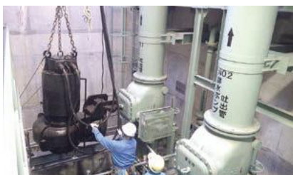
今里雨水ポンプ場 (排水ポンプの分解整備の様子)
