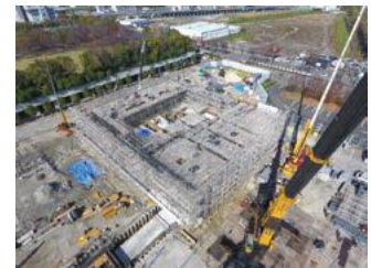
呑龍ポンプ場 (建設中) 令和2年11月26日撮影
