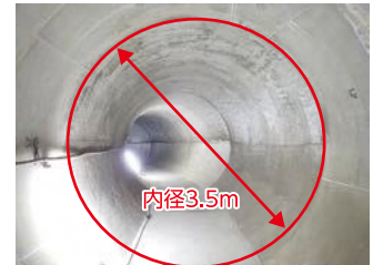
いろは呑龍トンネル (内部)
