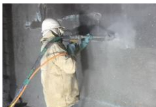
ウォータージェットによる塗装撤去作業の様子
