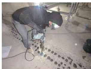
鉄筋の打ち込み作業の様子
