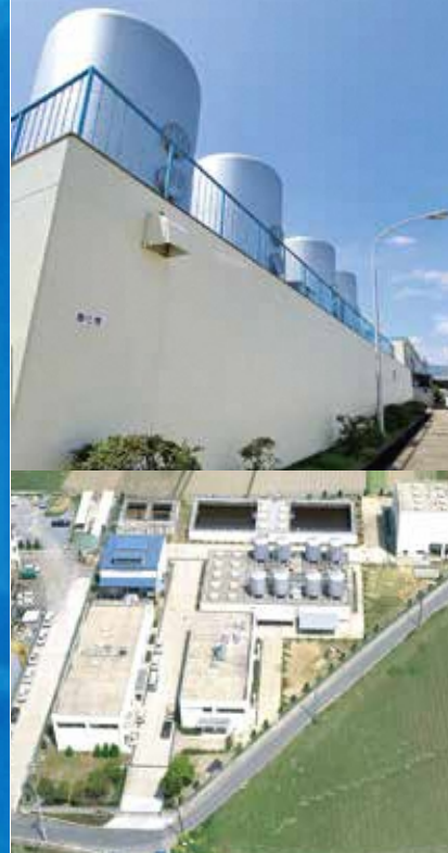
東第2浄水場 浄水池(管理棟地下)
