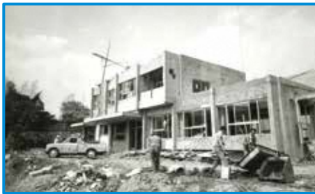
▲長法寺浄水場 現:廃止
