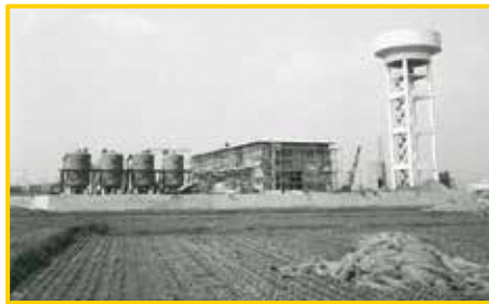
●東浄水場 現:東ポンプ場(勝竜寺)
