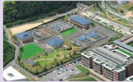
●乙訓浄水場 (京都府営水道)
