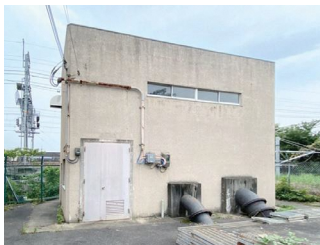
現在の雨水ポンプ場
