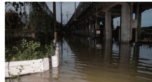
写真：平成22年(2010年)7月の大雨 長岡京市神足十ヶ坪で新幹線の高架沿いの道路が内水氾濫により浸水。
