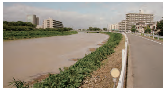
写真：平成25年(2013年)9月台風18号 水位が上昇した桂川に合流できず、小畑川の水位が越水手前まで上昇。写真は長岡京市神足太田付近。
