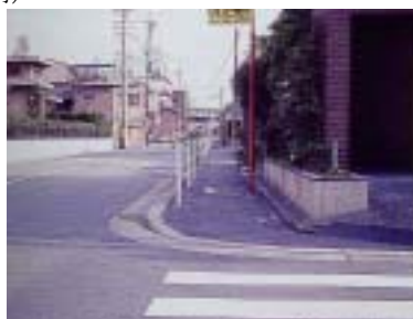
波打ち歩道の改良（他都市の例） （改善前）
