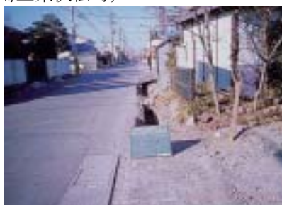
道路計画とあわせた交通規制による歩行空間の確保（埼玉県伏松町）
