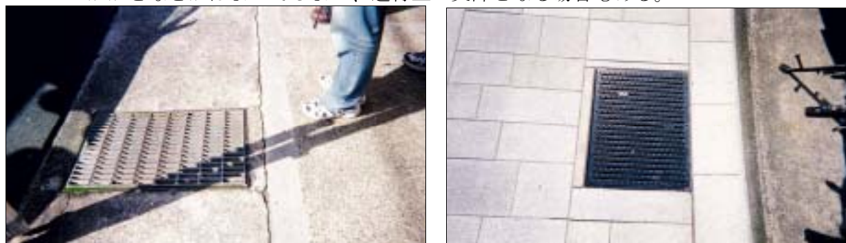
長岡京市内のグレーチング（左：網目が粗いタイプ、右：西国街道にある網目が密なタイプ）
