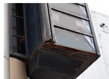
側板底面が腐食、破損した状態
