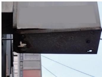
側板・表示面板押さえの変形・破損・部材の欠落
