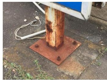
支柱根元の腐食、支柱と基礎部分・巻きに生じた隙間、支柱ぐらつき
