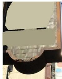
広告板底部の腐食、水抜き穴の詰まり
