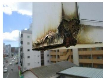
側板の腐食が進行した状態
