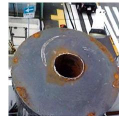
鉄骨接合部（プレート）が破損している状態
