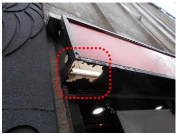
広告板底部の腐食、水抜き穴の詰まり
