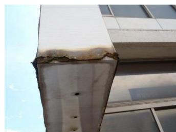
側板の腐食が進行した状態
