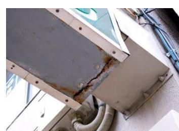
側板底面が破損した状態
