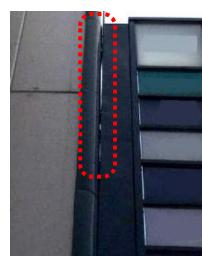
壁面との間に隙間が生じた状態
