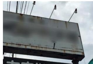
表示面の継ぎ目からさびが垂れた状態
