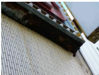
取付部の腐食が進行、汚ダレが見
