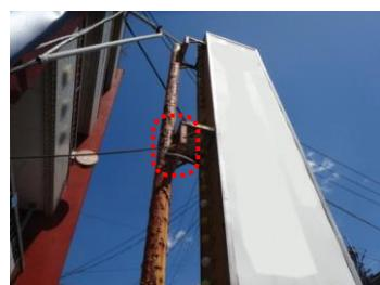
支柱・広告板接合部の腐食・隙間
