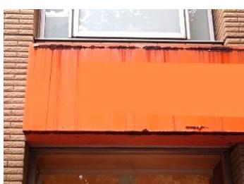
側板の腐食が進行した状態
