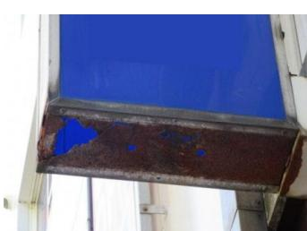
側板底面が腐食、破損した状態
