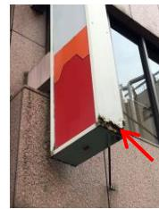
広告板底部の腐食が進行した状態
