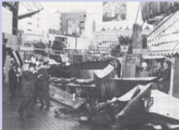
台風で落下した時の様子
