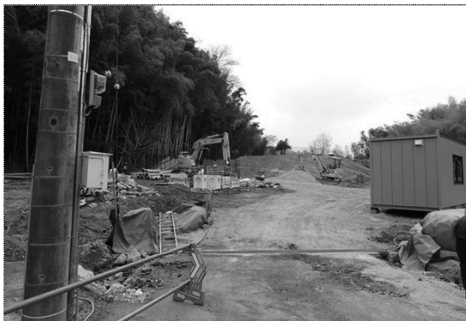
現場全景(出入口より見る)
