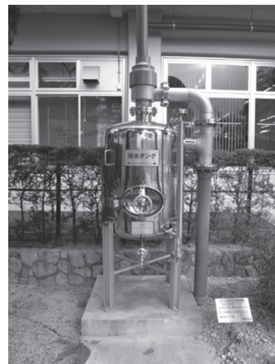
治水対策などにも有効な雨水貯留タンク （長岡京市役所前）
