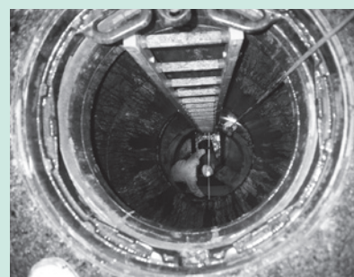
下水道管の調査（調子付近）
