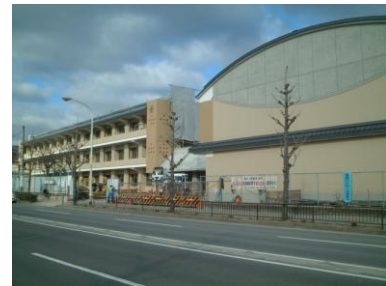
耐震化工事中の第七小学校
