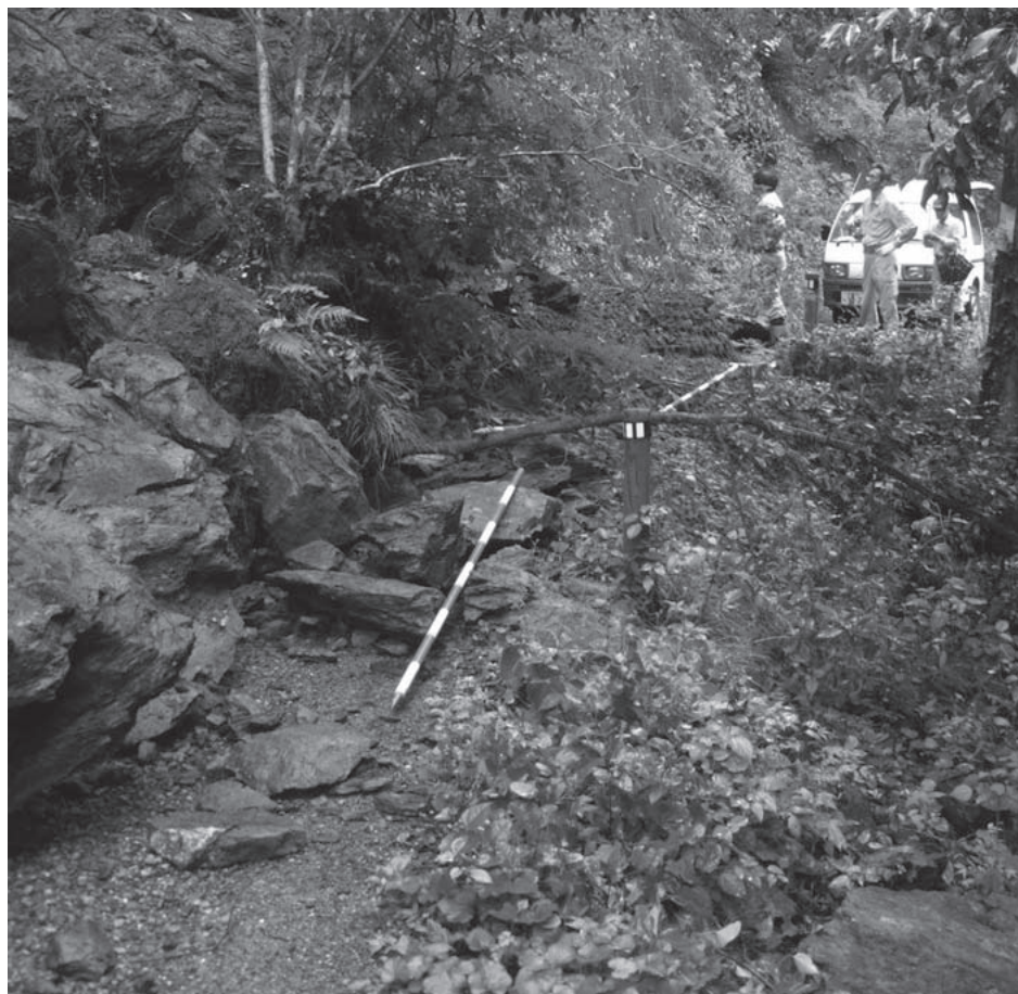
▲7月13日に発生した鉢伏林道(奥海印寺)の土砂崩れ
