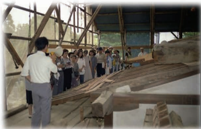
市指定文化財の乙訓寺本堂解体修理現場見学会。阪神淡路大震災で大きな被害を受け、復興に取り組む（平成9年）。
