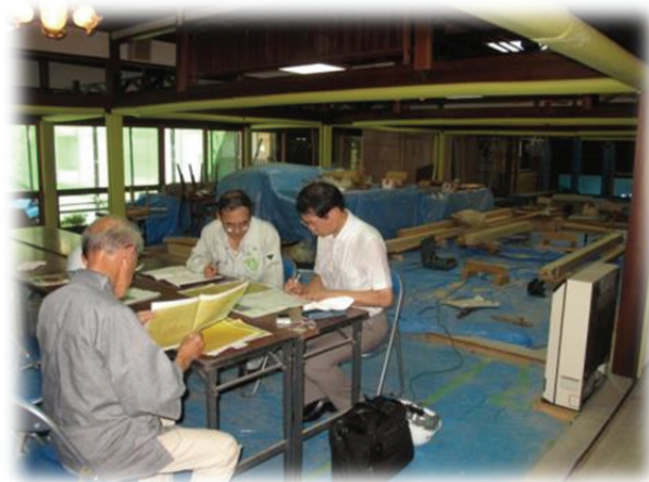
長岡天満宮社務所の耐震工事。平成23年3月に本殿が京都府指定文化財に、平成24年11月にこの社務所ほか10棟が長岡京市指定文化財となりました。
