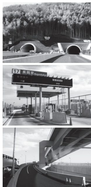
●長岡京 IC 周辺の写真 ①西山トンネル入口／②大山崎方面への上り口 ③大山崎方面
